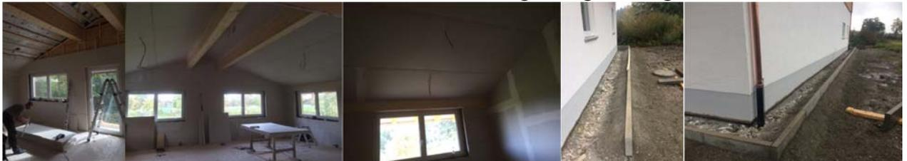
08.10.2016 Heute konnten tatsächlich die Rigipsarbeiten abgeschlossen werden. 7 Bergwachtler haben die restlichen Außen- Innenwände und Decken fertig gemacht. Im Obergeschoss wurde auch gleich schon gespachtelt und es konnte auch schon mal etwas aufgeräumt werden....
