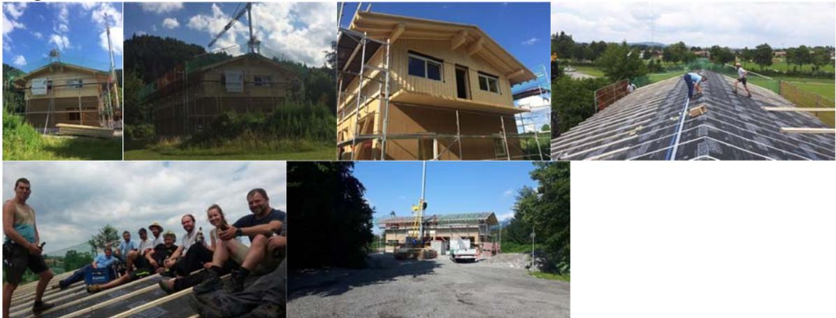
18.07.2016 Heute wurde der Kamin mit integriertem Ofen eingesetzt und es wurde die gesamte Dachlattung montiert. Morgen können die Dachplatten auf das Dach ☺
