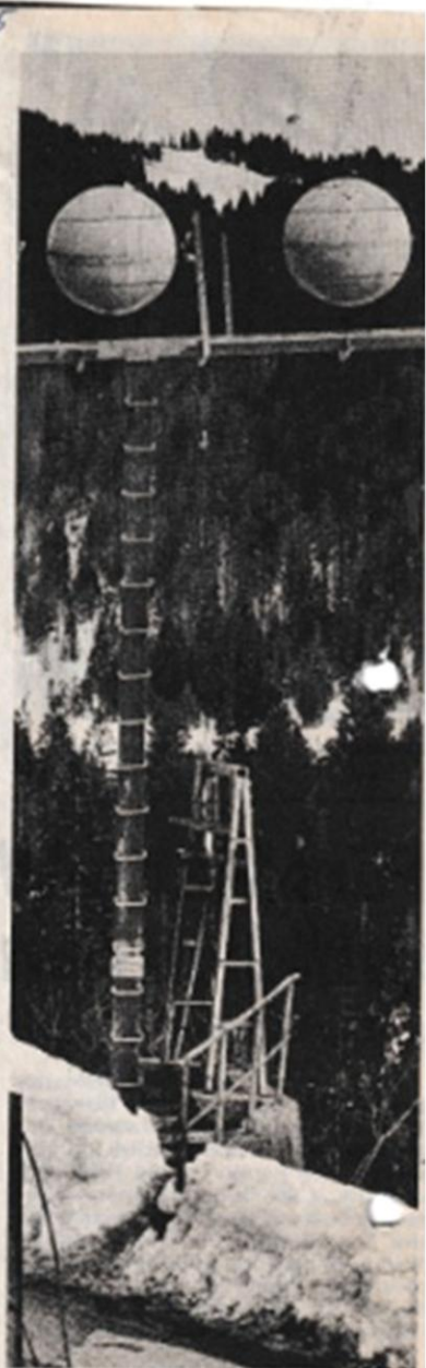
Diese Warnkugeln an der Talstation der Seilbahn werden von Piloten beanstandet. Durch Erosion sind sie von oben weiß und im Schnee nicht erkennbar. Foto: Ralf Lienert
